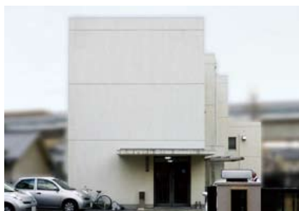
サービサー兵庫営業所
